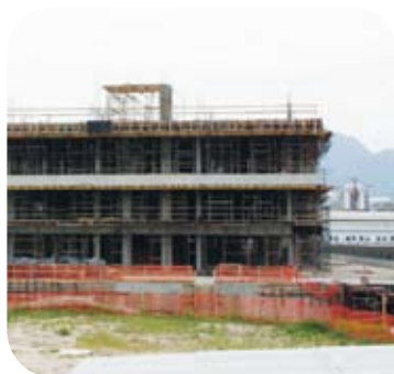
2010: Obras avançadas, com término previsto para Julho de 2011
