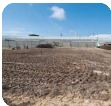
Março de 2009: Começo das obras do Hospital
